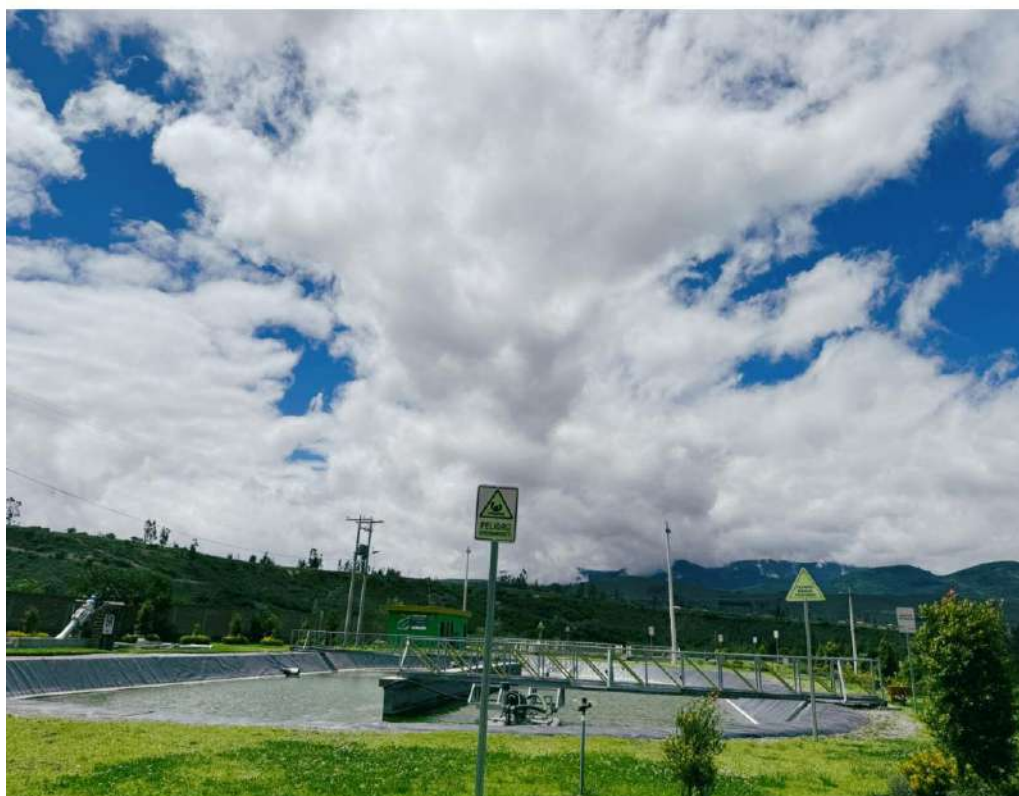
Fotografía 40 Planta de tratamiento
