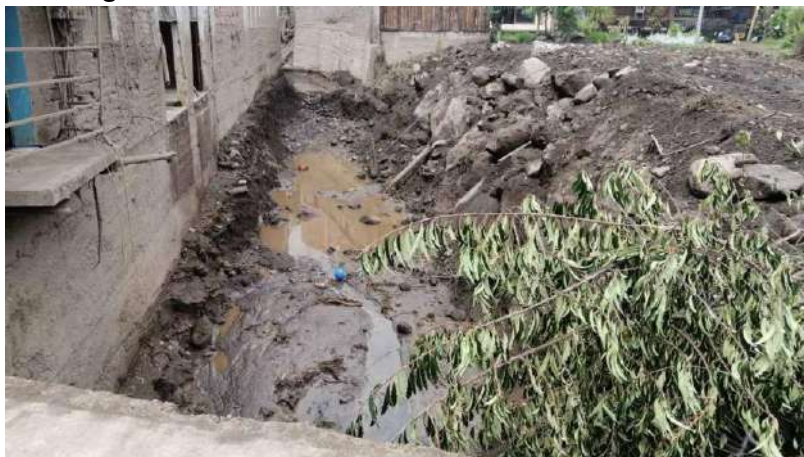
Fotografía 17 Inundación área urbana cantón Guano
