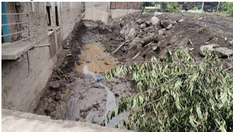
Fotografía 17 Inundación área urbana cantón Guano
