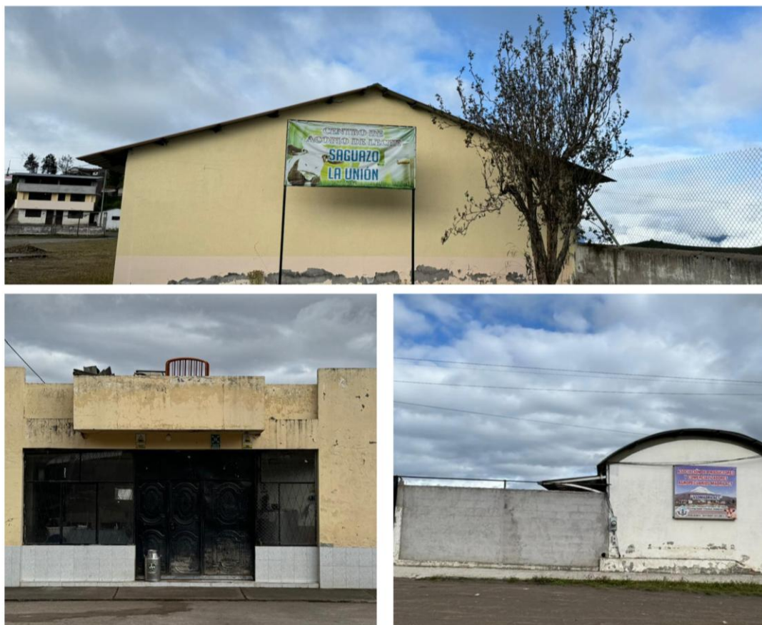
Fotografía 44 Centro de acopio
